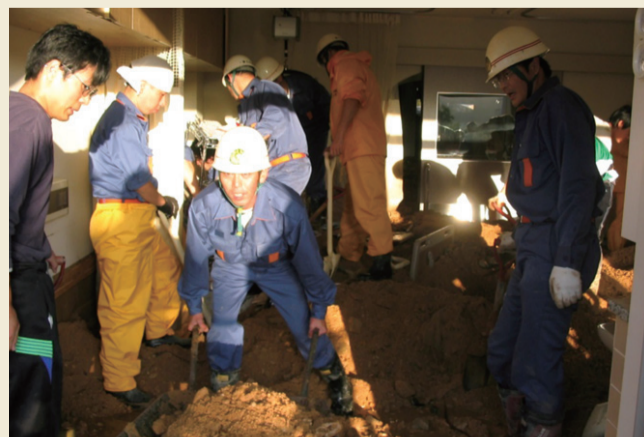
復旧作業をする消防団員(10月21日)
