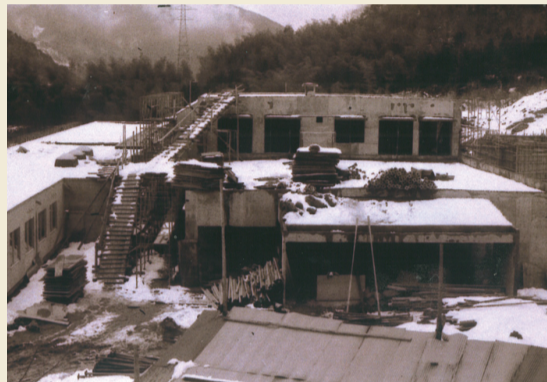
建設中の恵生園
