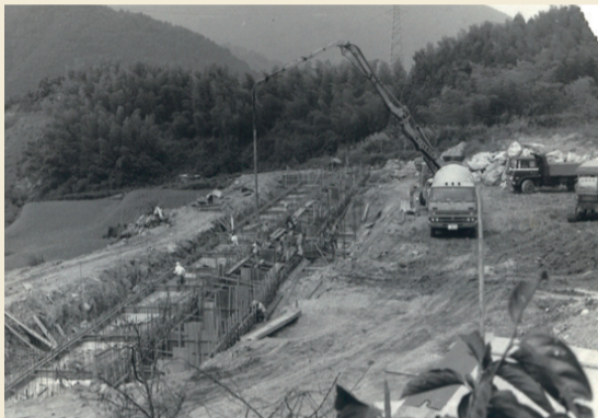
建設中の恵生園
